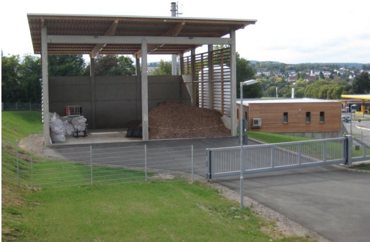
Offene Halle am Heizwerk Wetter für die Beschickung des Biomasseheizwerks mit Holzhackschnitteln.
