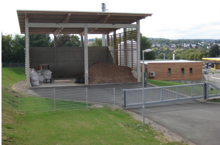
Offene Halle am Heizwerk Wetter für die Beschickung des Biomasseheizwerks mit Holzhackschnitzeln.
