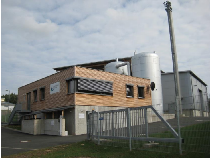
Betriebsgebäude am Heizwerk Wetter, Marburger Str. 67.
